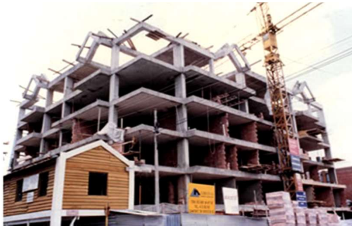
CONSTRUCCIÓN DE LA CIMENTACIÓN Y LA ESTRUCTURA "EDIFICIO APOSENTOS"
