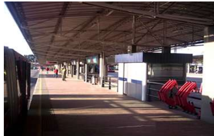
CONSTRUCCIÓN DE LA TERMINAL DE CABECERA EN LA CALLE 63 SUR POR LA TRONCAL CARACAS - TRANSMILENIO
