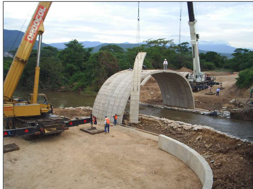
CONSTRUCCIÓN PUENTE DOÑA RAQUE, LA MINA, GUAJIRA CARBONES DEL CERREJÓN LIMITED
