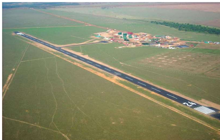
CONSTRUCCIÓN PISTA DE ATERRIZAJE EN JAGUAR 1 – PUERTO GAÍTAN, META - CEPCOLSA
