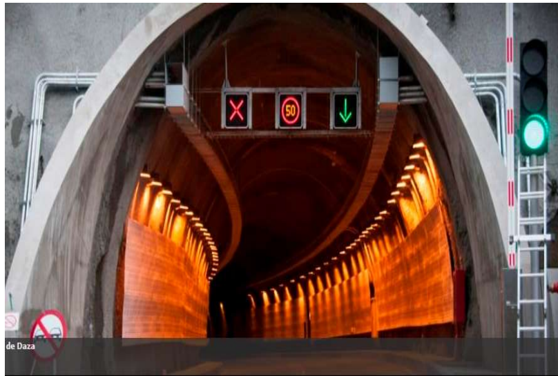
CONSTRUCCION DEL TUNEL DAZA CONCESIÓN RUMICHACA – PASTO - INSTITUTO NACIONAL DE CONCESIONES.
