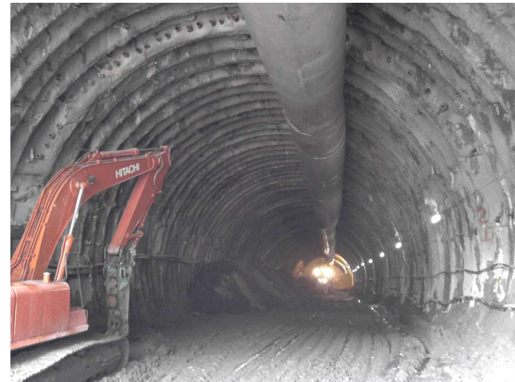
INVIAS. CONSTRUCCIÓN DEL 670 ML TÚNELES VEHICULARES CALZADA QUINDIO (PROYECTO CRUCE CORDILLERA CENTRAL).
