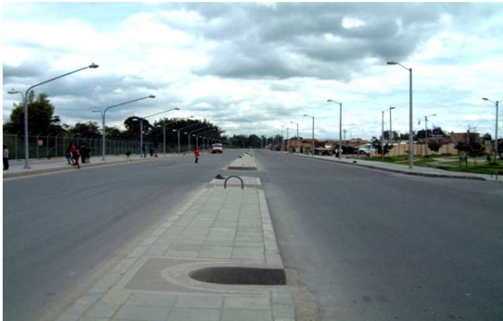
CONSTRUCCIÓN DE LA AVENCIDA JOSÉ CELESTINO MUTIS SECTOR AVENIDA CIUDAD DE CALI A LA CARRERA 119 BOGOTÁ D.C.- IDU
